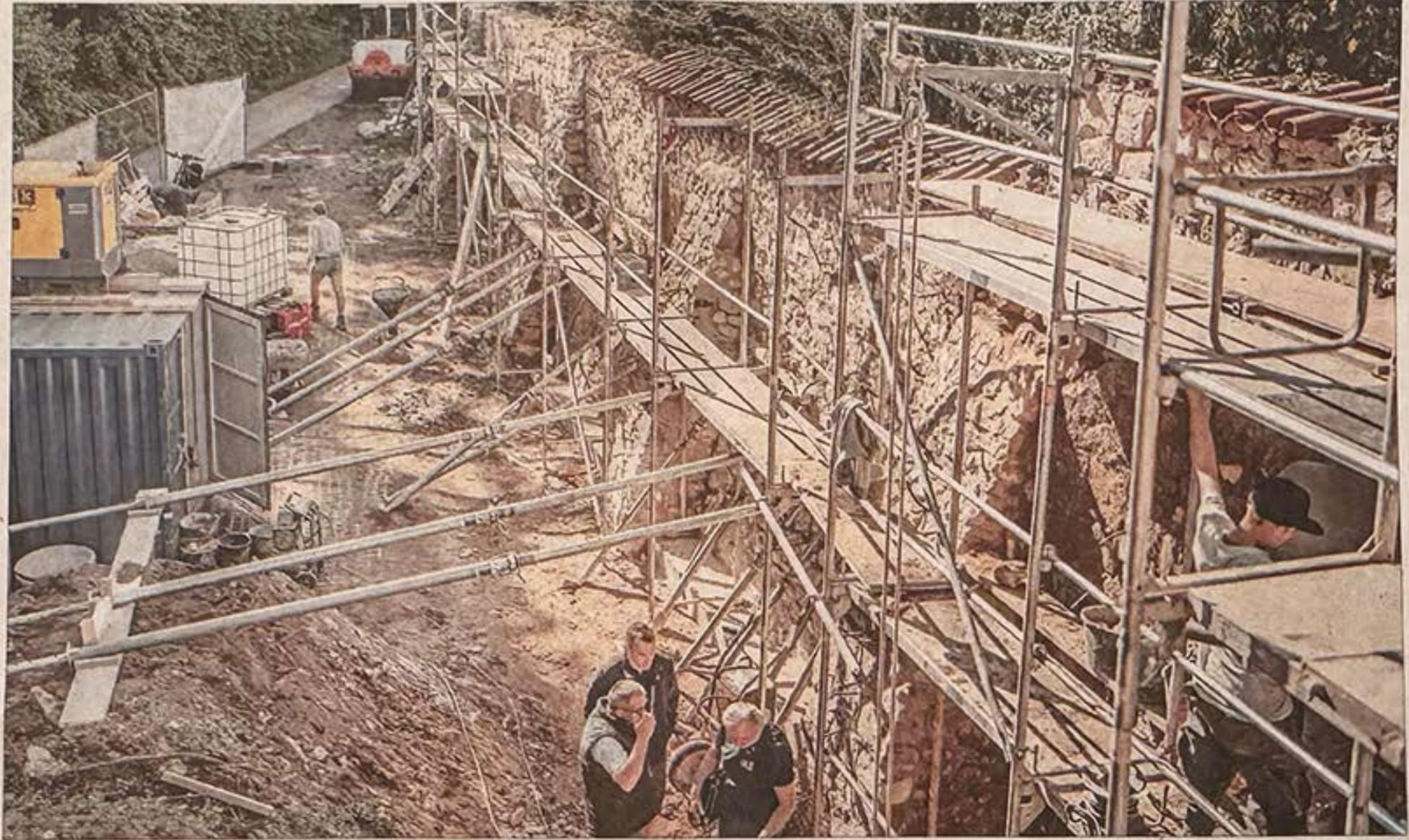
Die Sanierung der Stadtmauer im Abschnitt unterhalb der Bahnhofs-Apotheke geht weiter. Hier sind die Schäden im Mauerwerk größer als zunächst angenommen.
